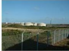
LNG tanks South Hook, Wales
